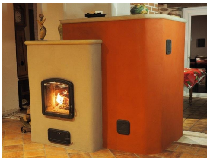
Foyer à accumulation en « îlot central » ou « en écharpe » autour d'un mur. ©Terrafeu
