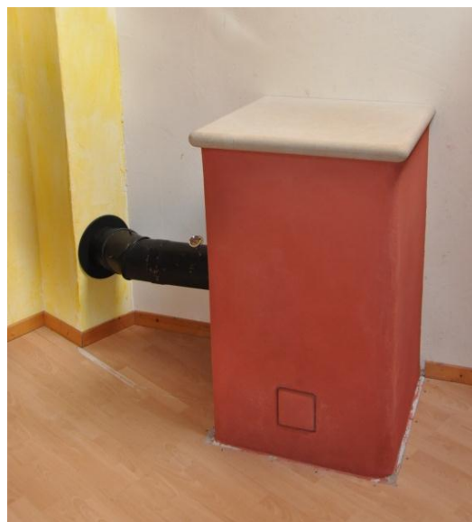
Foyer à accumulation « traversant » : la partie supérieure de l'ouvrage qui se termine à l'étage (ci-dessus) permet de décentraliser une partie de la chaleur. ©Terrafeu
