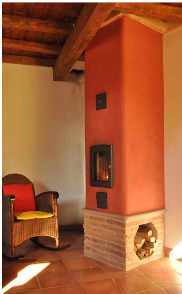
Foyer à accumulation « traversant » : la partie supérieure de l'ouvrage qui se termine à l'étage (ci-dessus) permet de décentraliser une partie de la chaleur. ©Terrafeu
