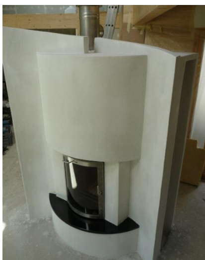
Foyer à accumulation en « îlot central » ou « en écharpe » autour d'un mur. ©Terrafeu
